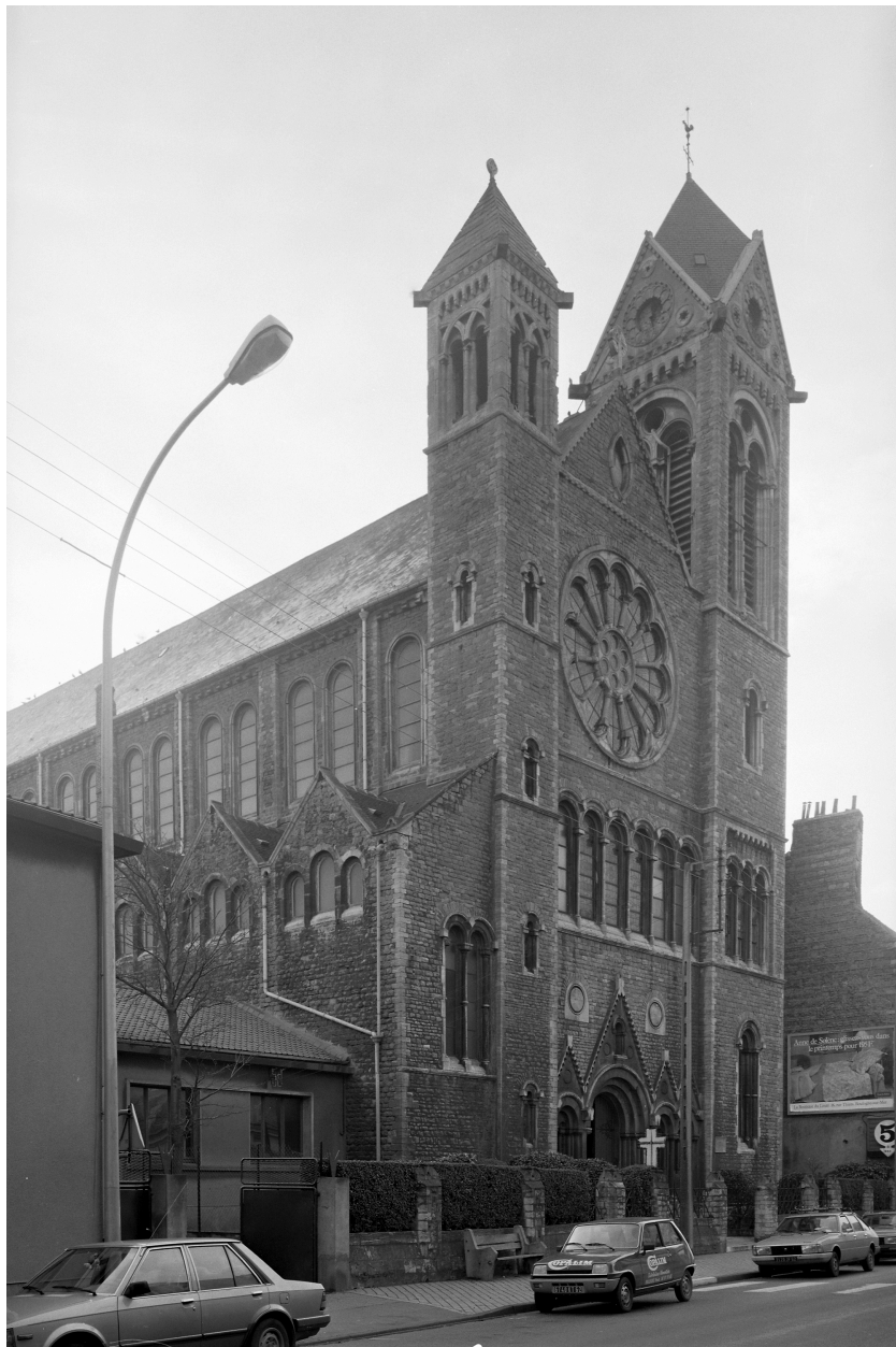
Vue d'angle rue de Brecquerecque.
