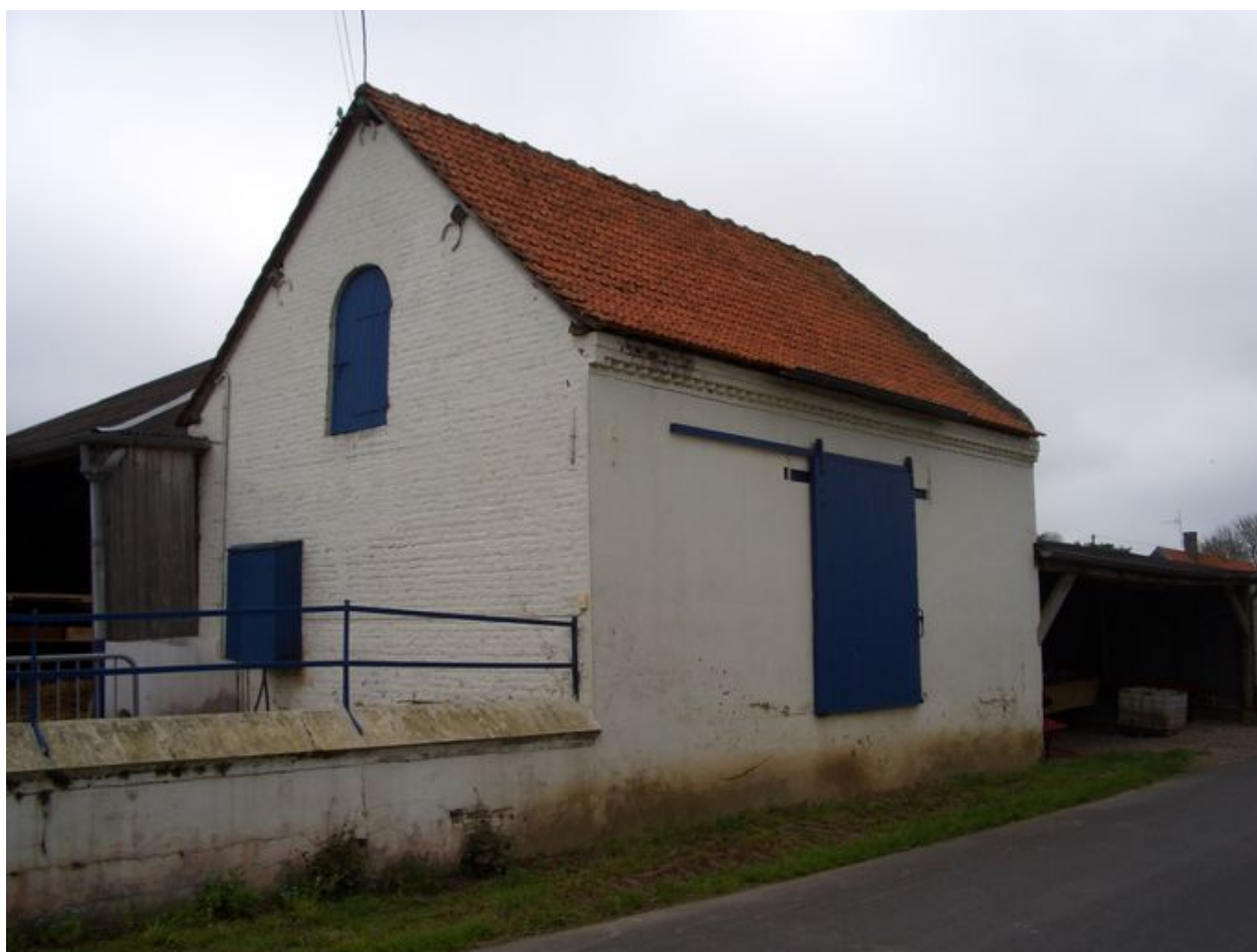
Vue de la grange sur rue.
