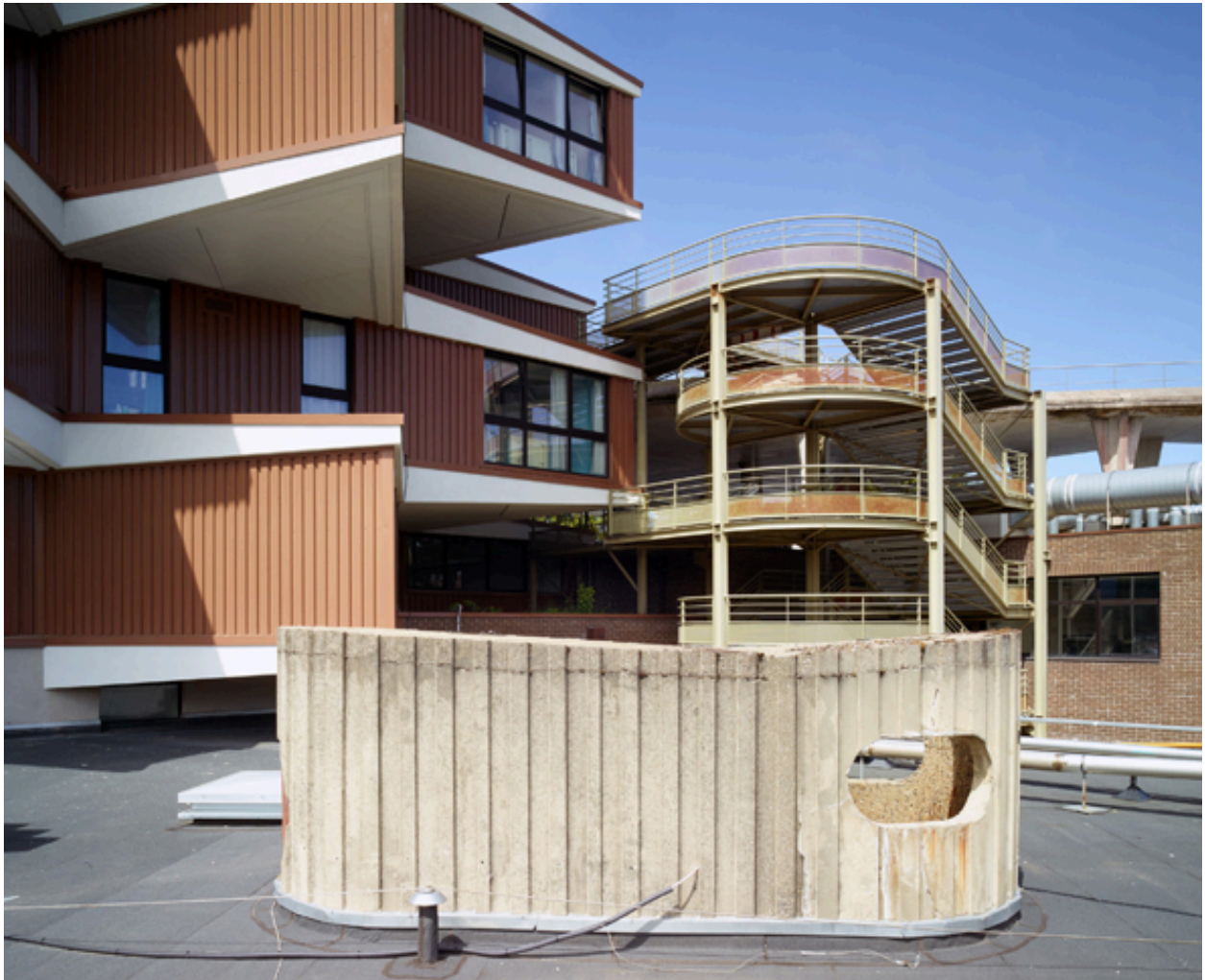
Vue de la sortie de cheminée d'une salle d'enseignement technique, depuis la toiture du C.E.T.
