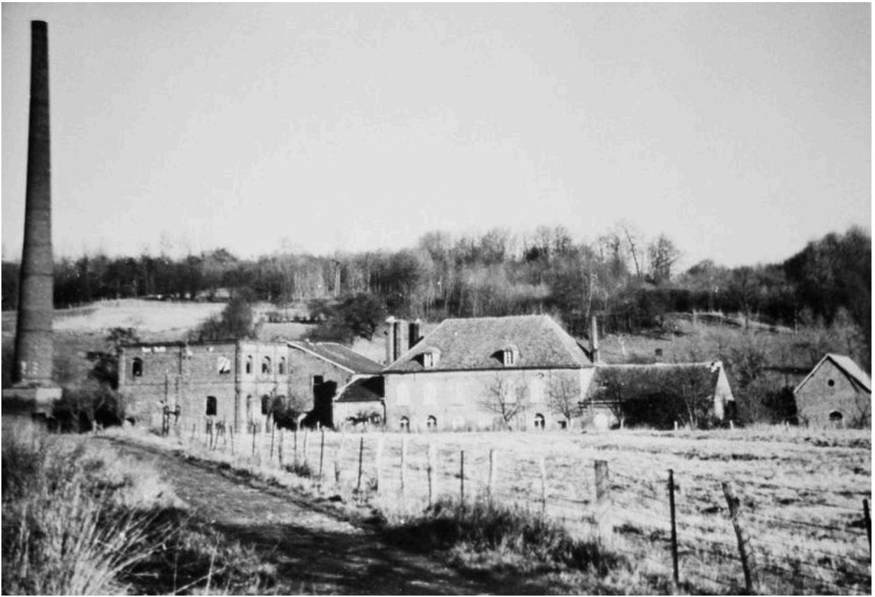
Vue générale des bâtiments de la sucrerie désaffectée, vers 1940 (AP).
