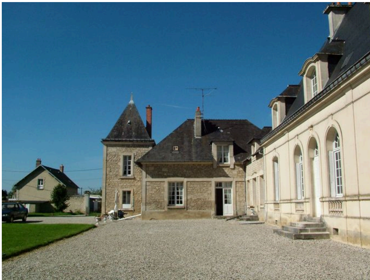
Vue antérieure de l'avant-corps gauche.
