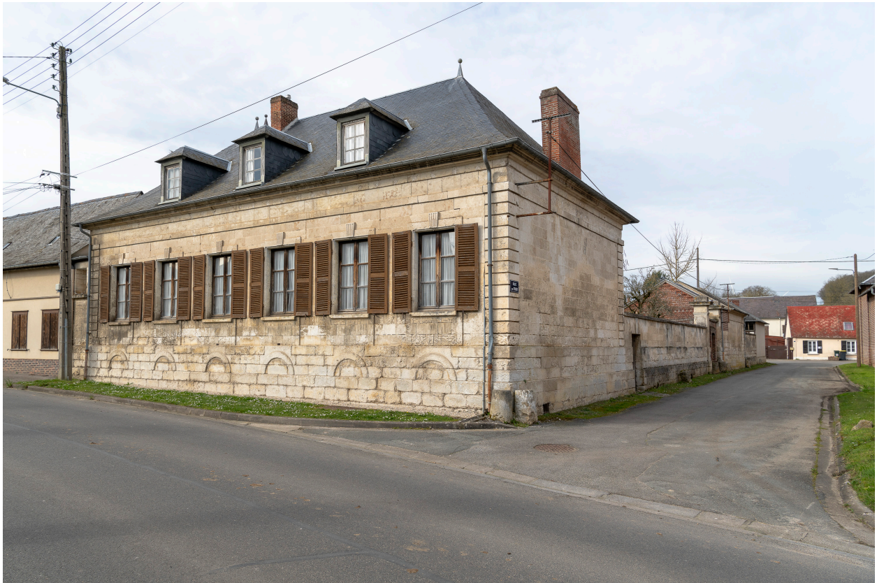
Demeure en pierre, n°1 de la rue Dufour, vue prise depuis le nord.
