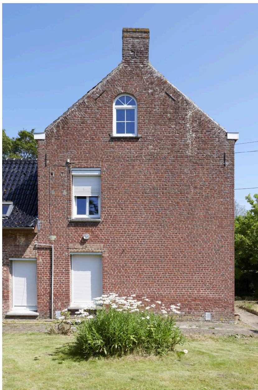
Détail du pignon ouest.
