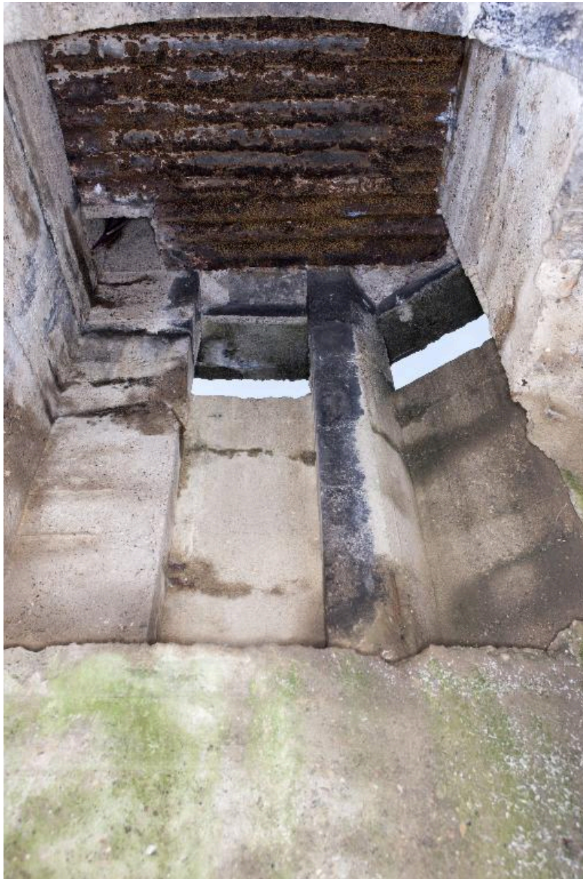
Le poste d'observation, en contre-plongée
