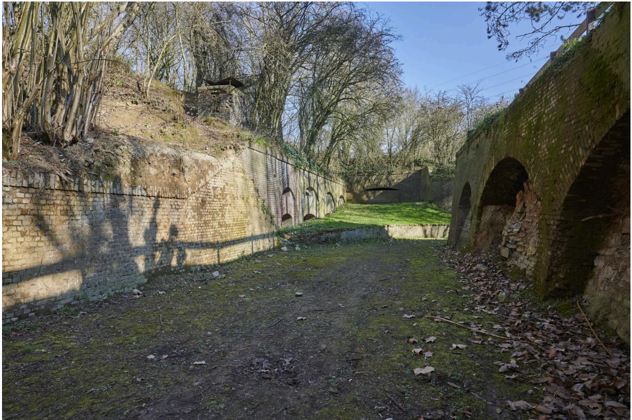
Le fossé sud-est vers le nord. Au fond, la caponnière simple.
