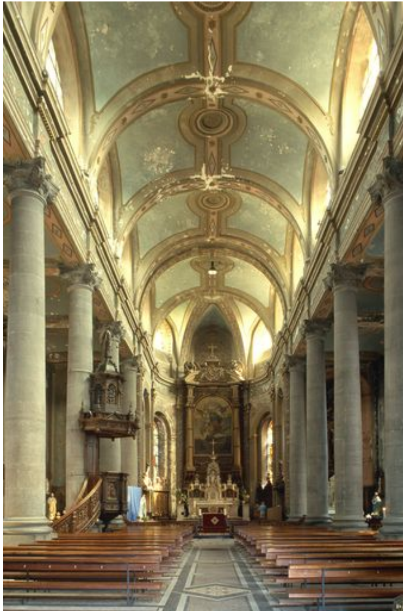
Intérieur : vue générale vers le chœur.
