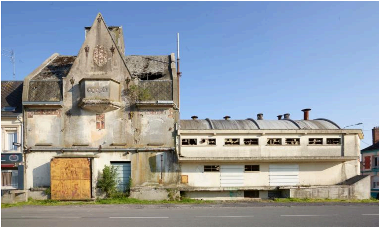
Vue générale. L'ancien hôtel Sheffield et l'extension de la coopérative agricole.
