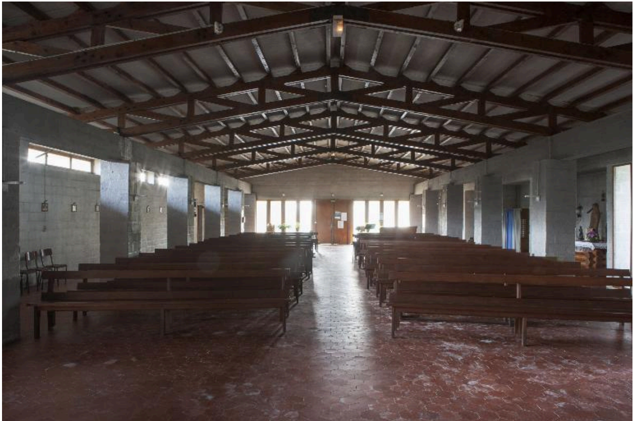
Vue générale depuis le chœur.
