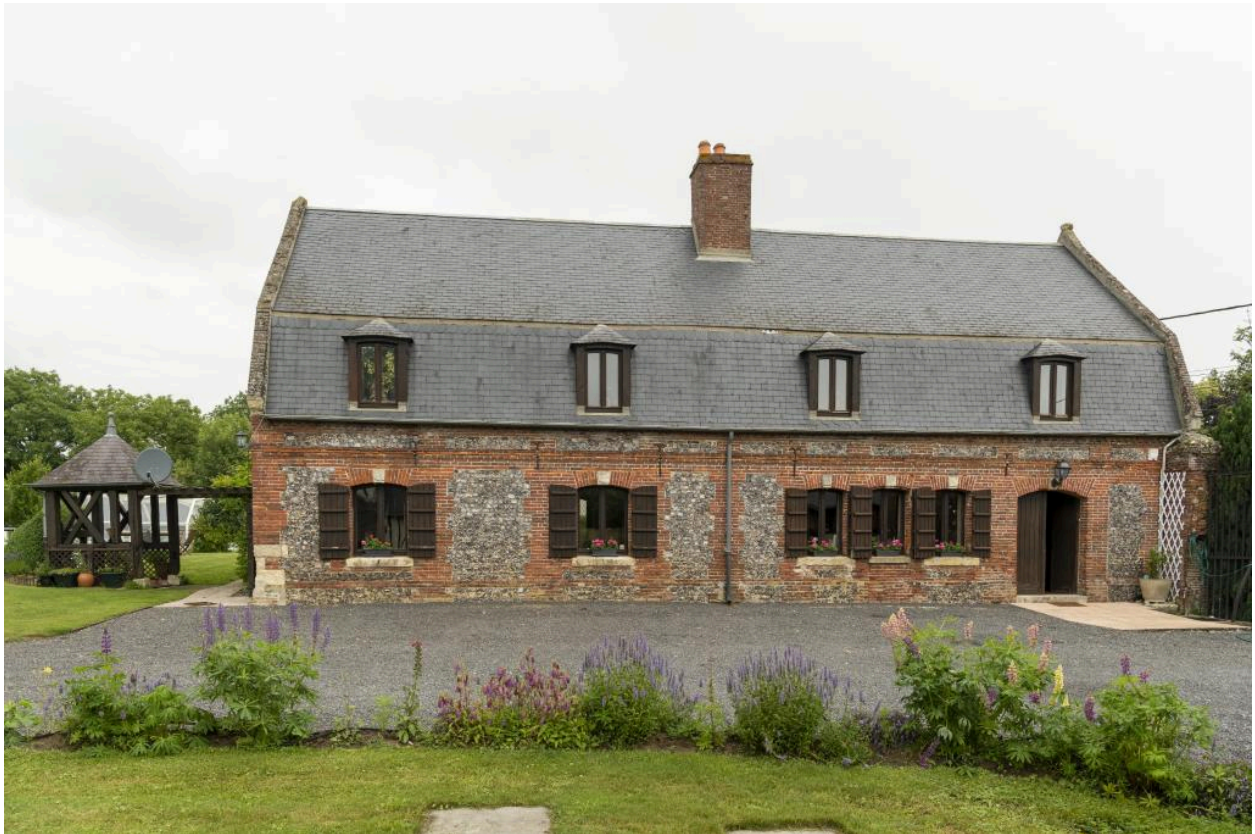
Vue du logis (ancienne maison du fermier ?) depuis la sud.
