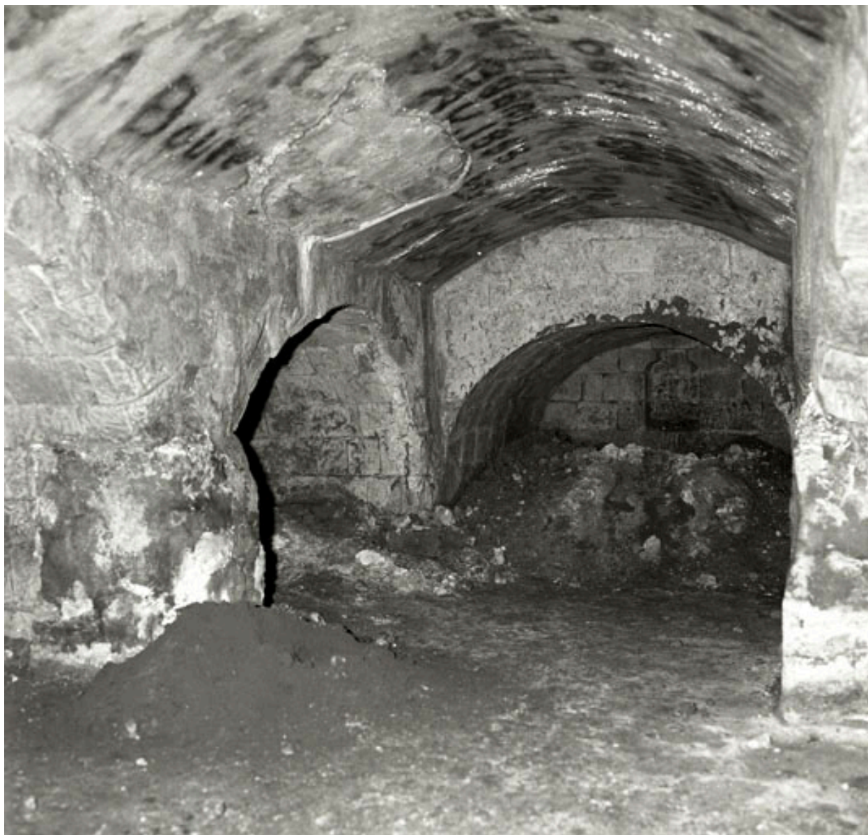
Sous-sol, vue partielle : ensemble de la cave 2, couloir central et cellule axiale.
