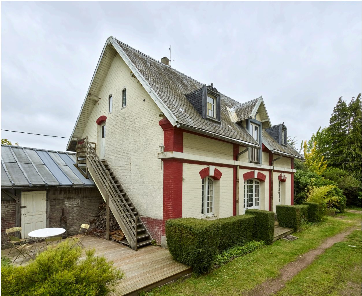
Vue de l'écurie, depuis le sud.
