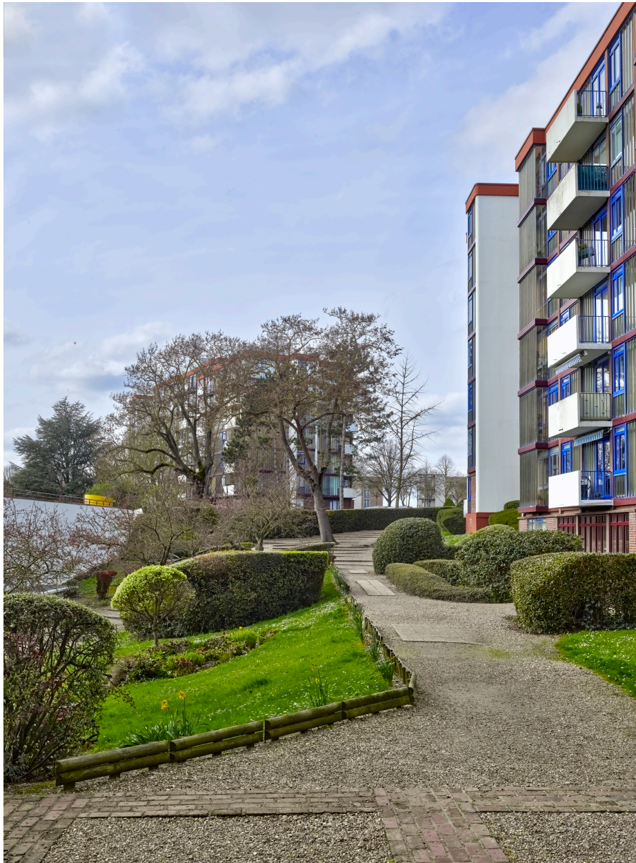
Cheminement le long du bâtiment E, vue depuis l'est.
