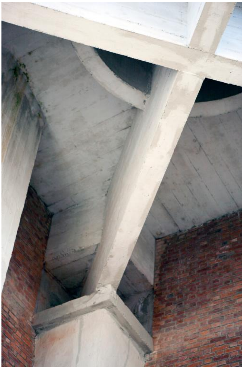
Vue intérieure du clocher. Détail de la structure supportant le campanile.
