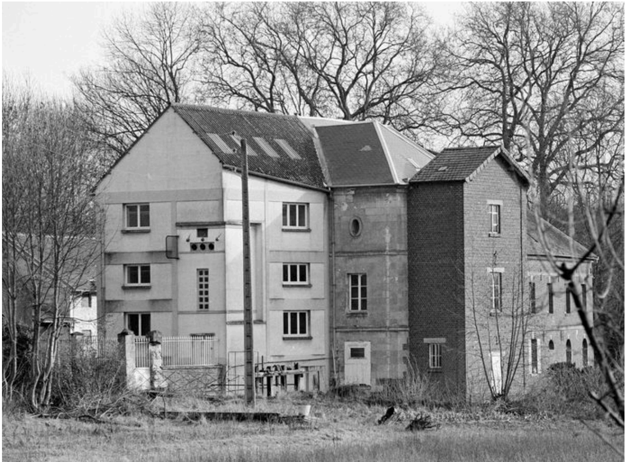
Vue générale, flanc nord ouest.
