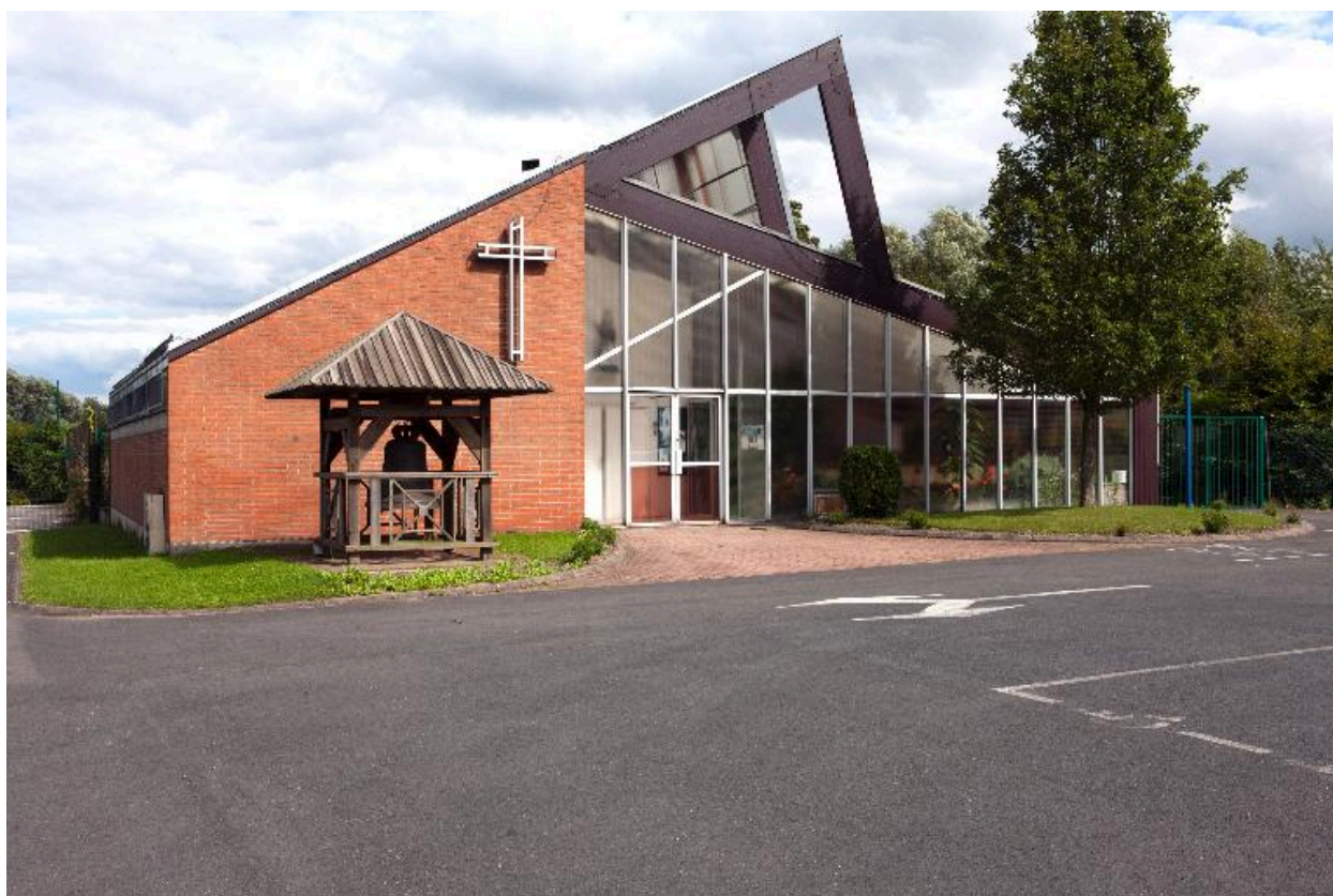
Vue de la façade occidentale.
