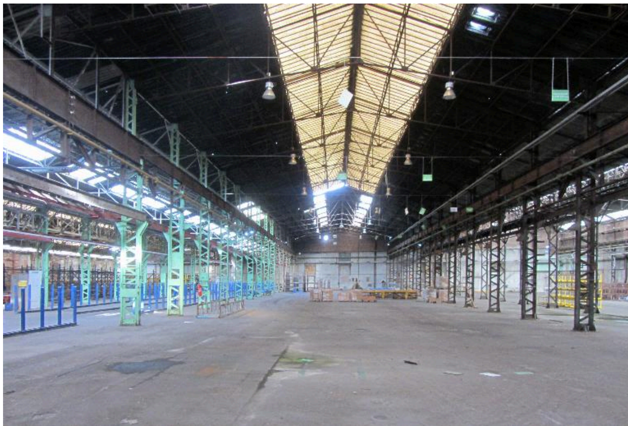
Vue intérieure d'une des halles de fabrication.
