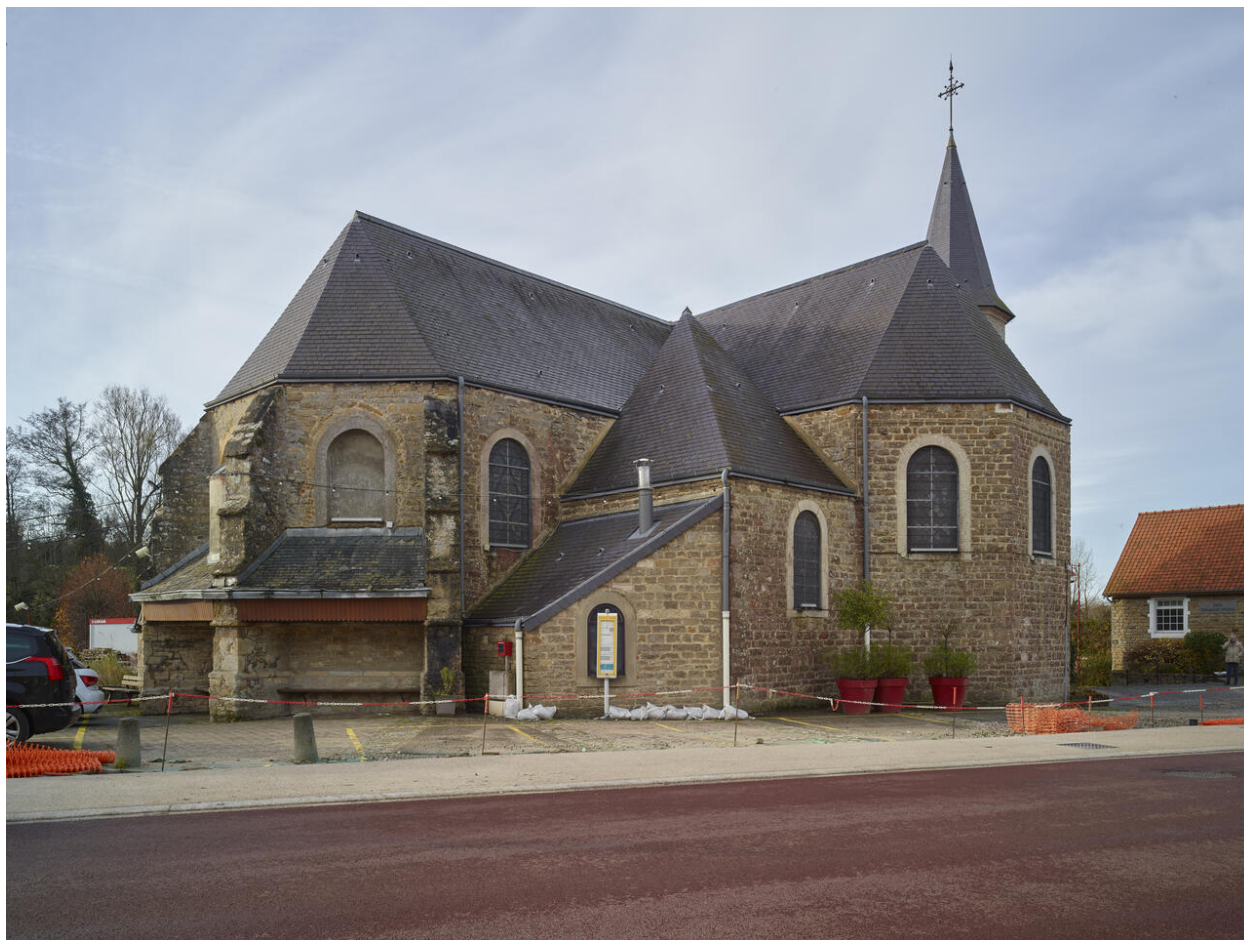
Vue de l'élévation nord.
