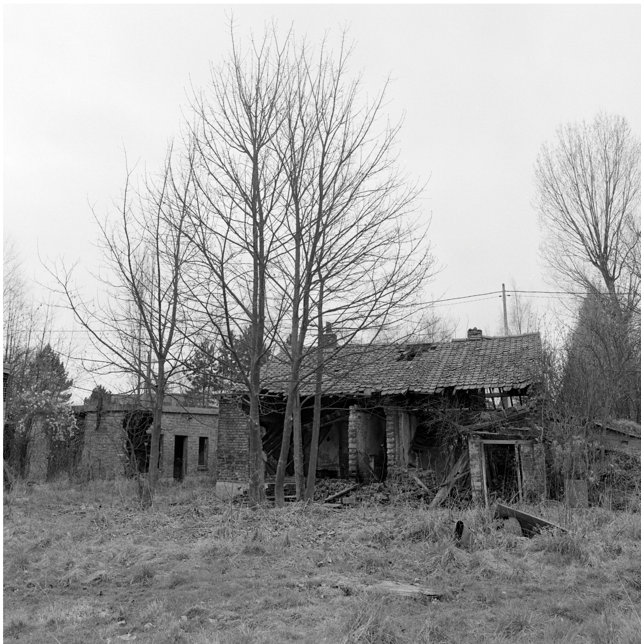
Vestiges des bureaux. Élévation postérieure.
