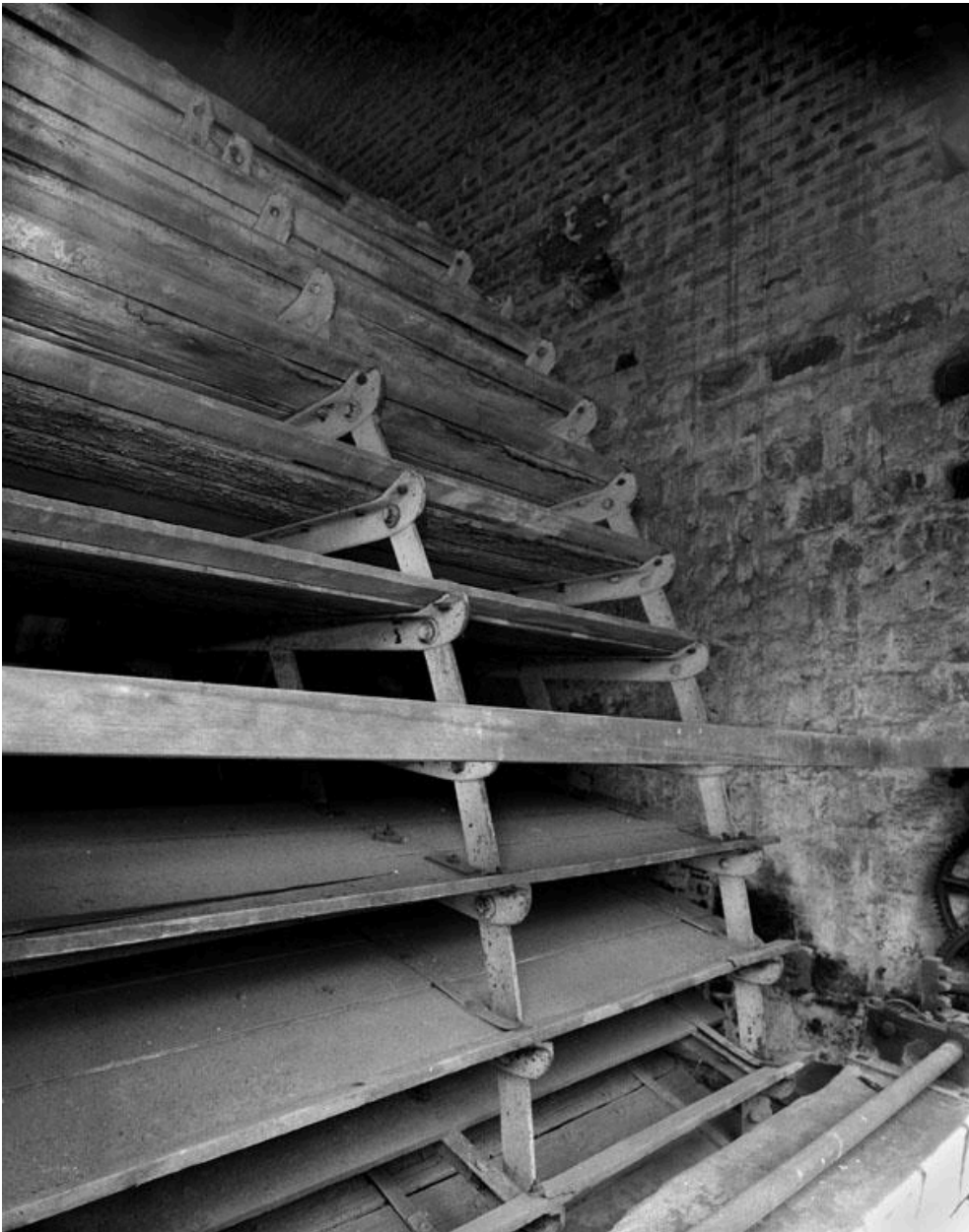
Détail de la roue hydraulique verticale et vue du bâtiment d'eau (intérieur).
