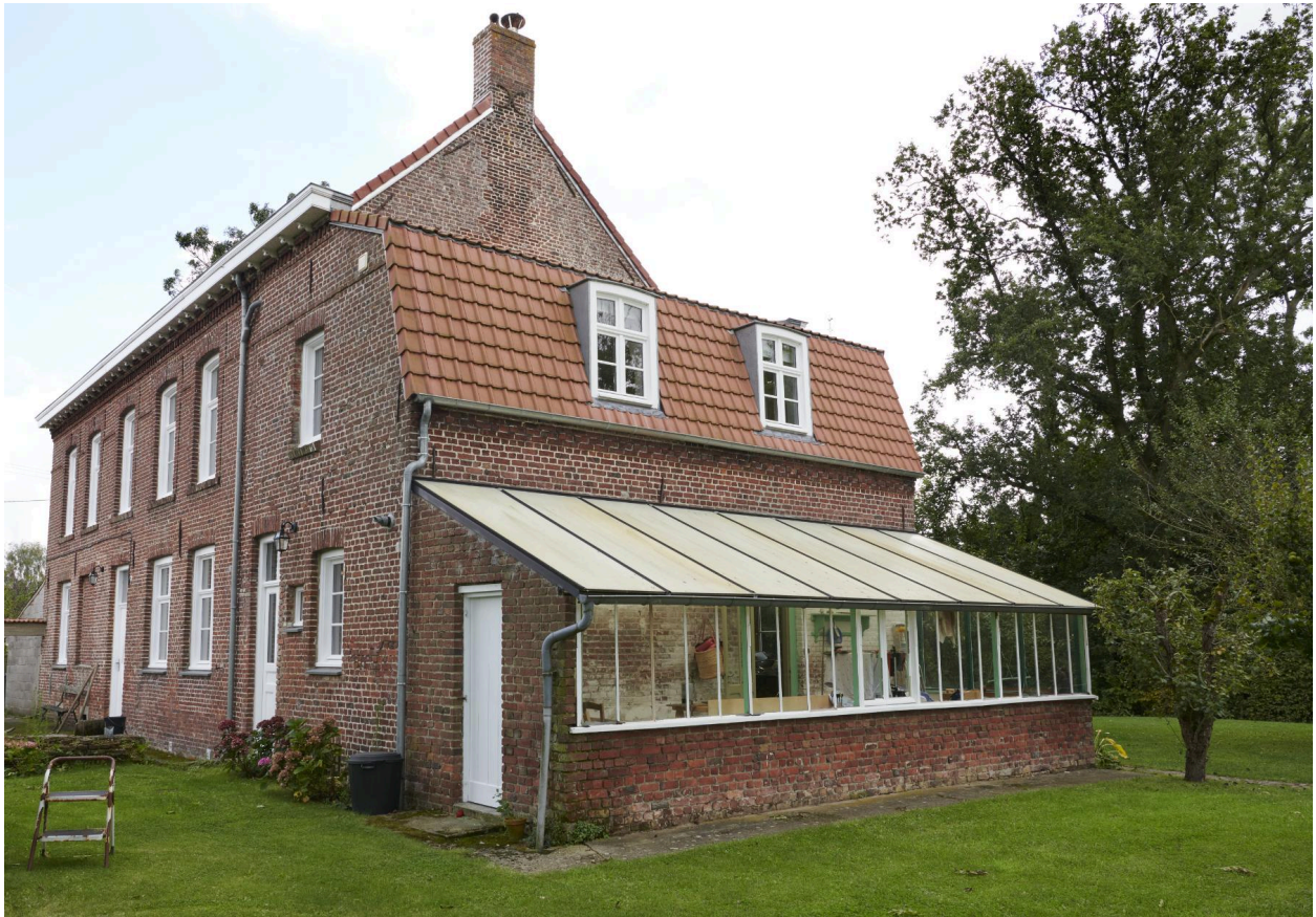
Pignon ouest et arrière du bâtiment.
