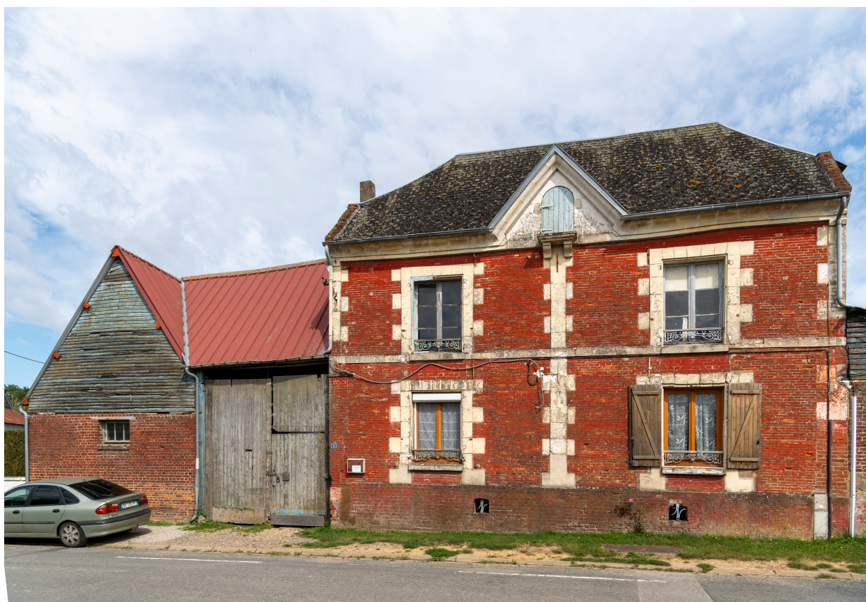
Ferme à cour : logis et entrée charretière sur la rue, n°8 de la Chaussée Brunehaut, vue depuis l'ouest.
