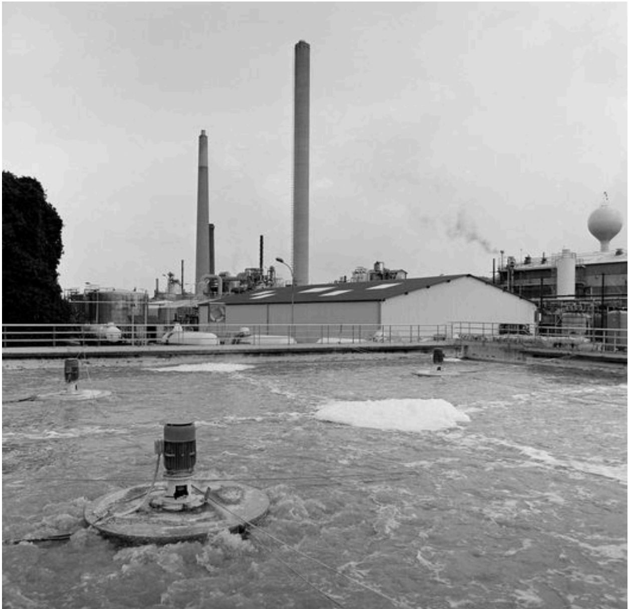
La station d'épuration construite vers 1970.
