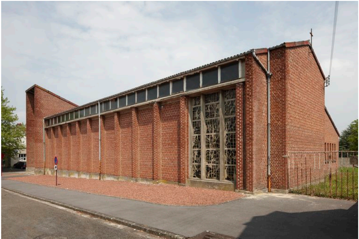
Vue du chevet et de l'élévation latérale.
