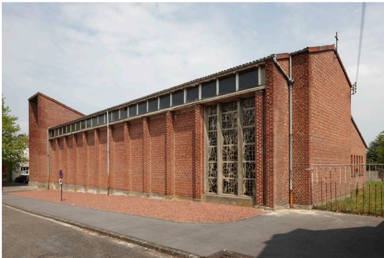
Vue du chevet et de l'élévation latérale.
