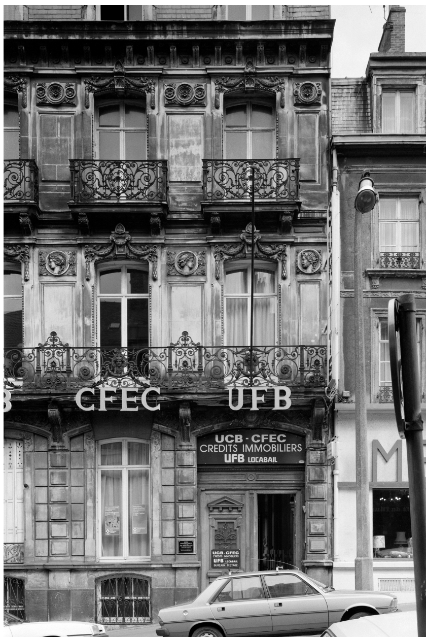
Façade partielle sur voie.
