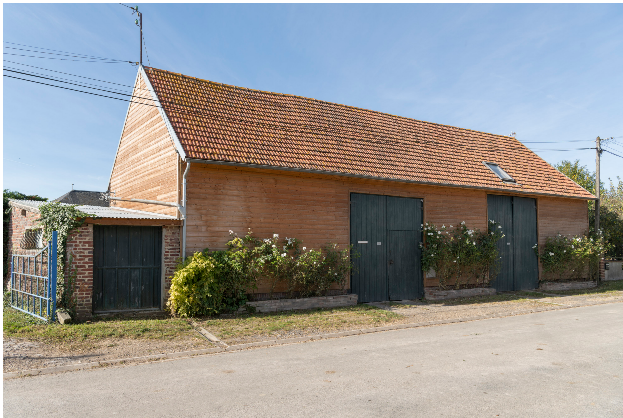
Grange avec essentage restauré, n°3 de la rue de Sérévillers, vue prise depuis l'est.
