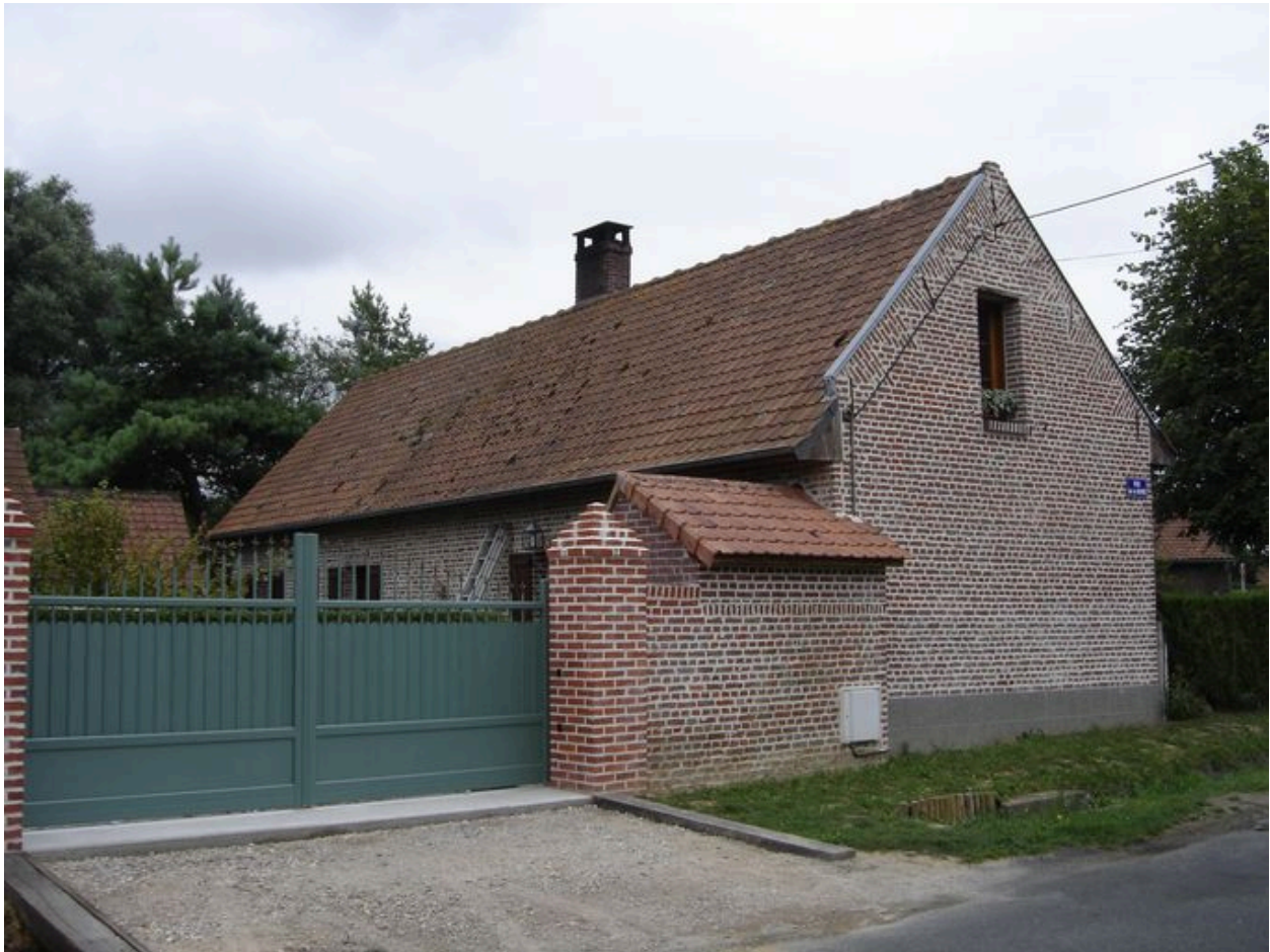
Vue postérieure du logis.
