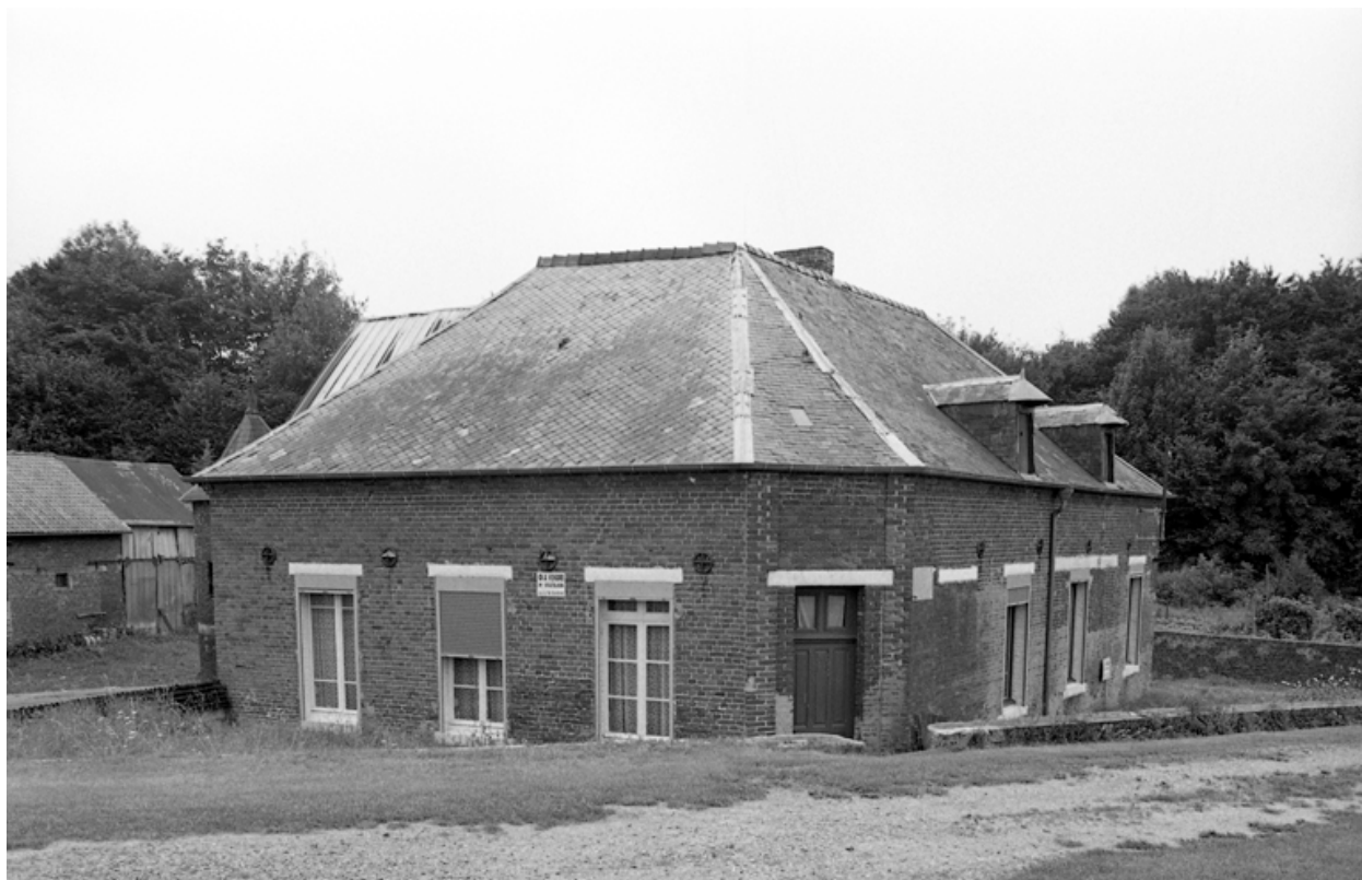
Vue d'ensemble du logis depuis le nord-ouest.
