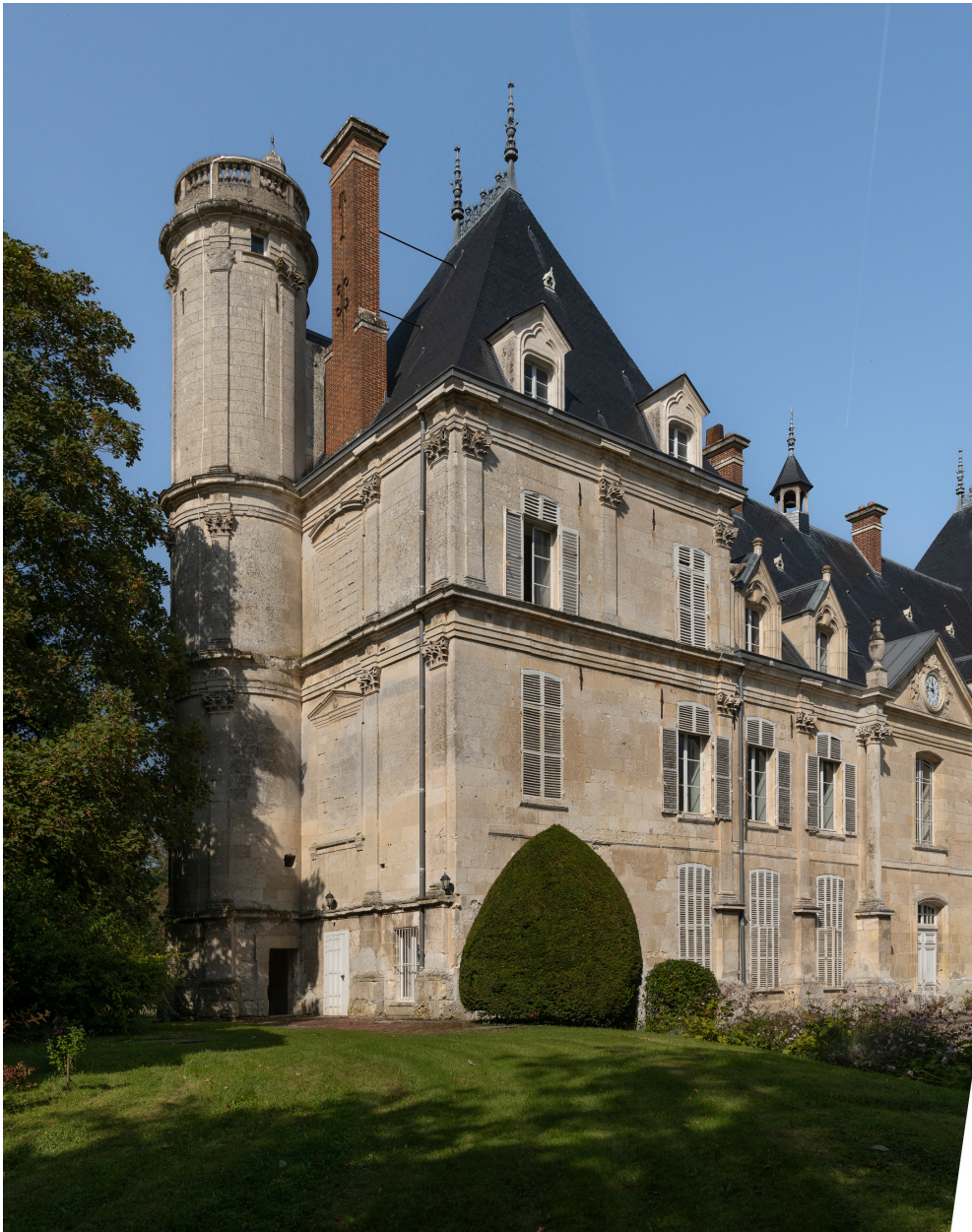
Élévation occidentale du château avec tourelle.
