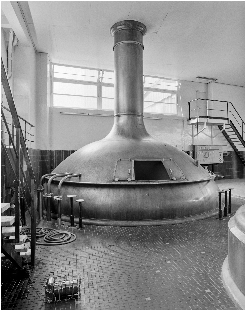
Salle de brassage, cuve à ébullition.
