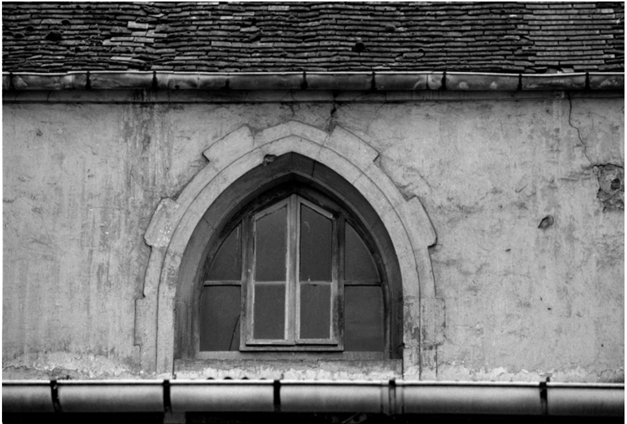
Détail d'une baie de la chapelle.
