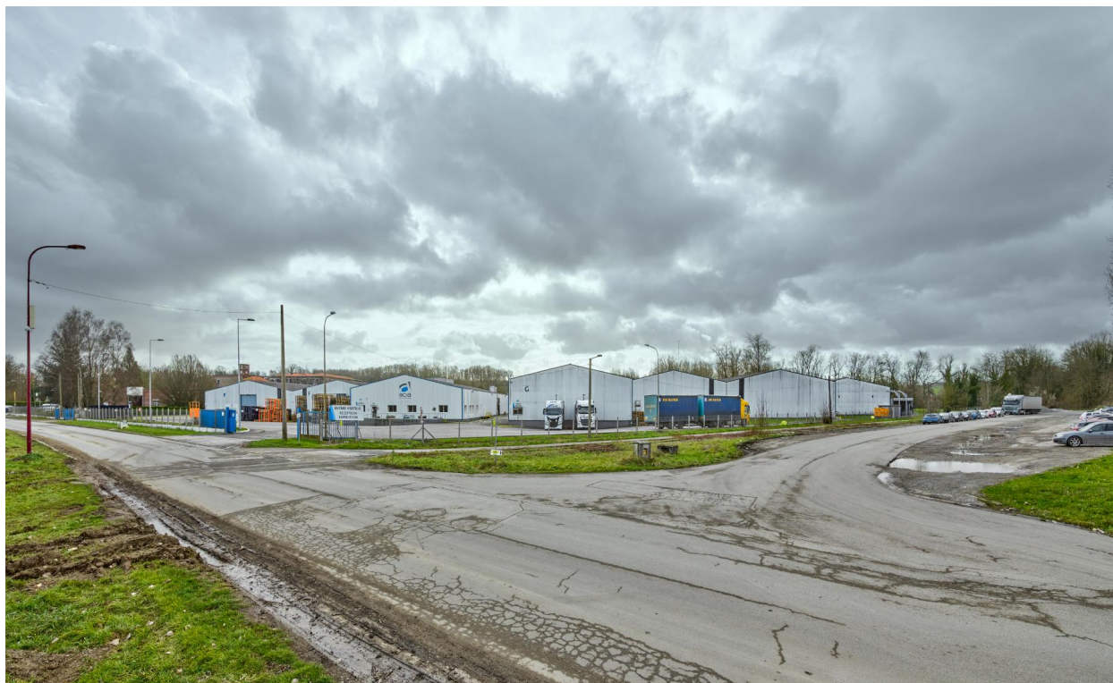
Vue d'ensemble des halles de fabrication de l'usine Acia construites après 1984.
