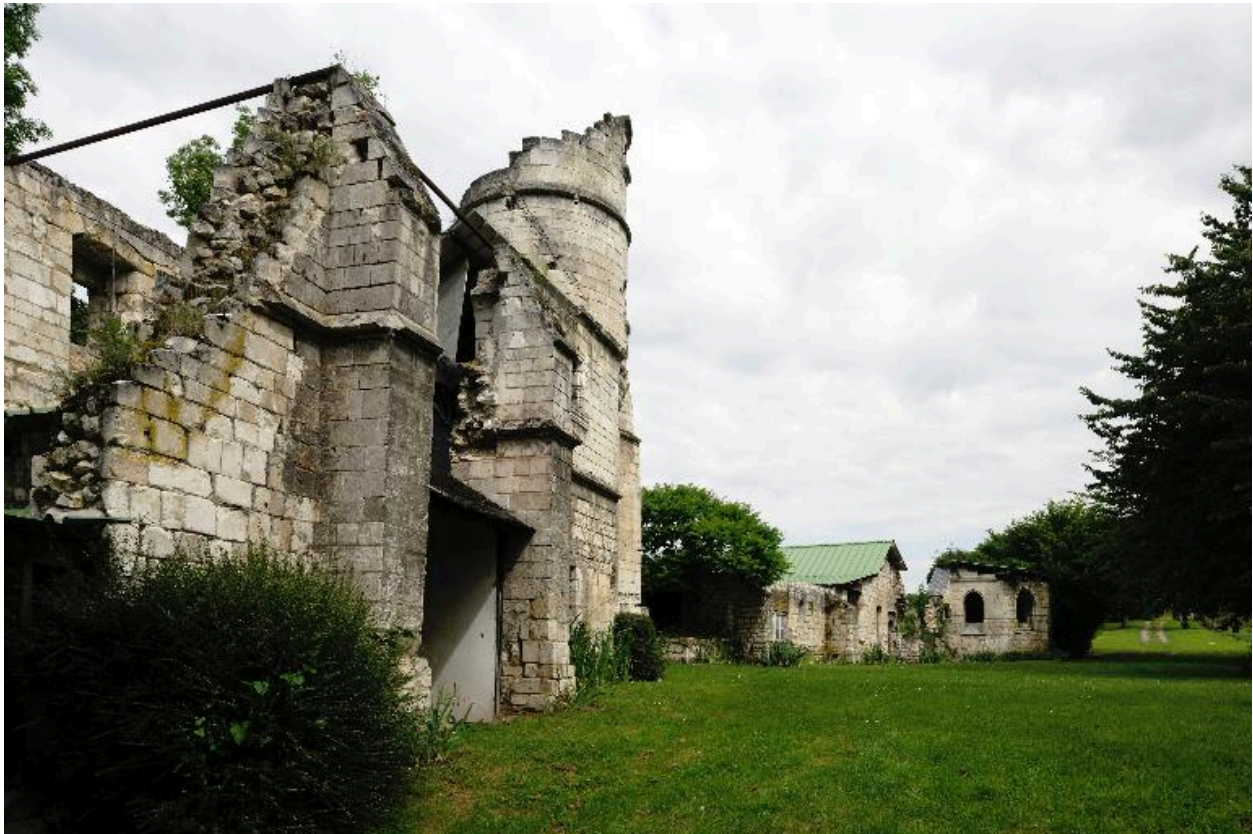
Vestiges de la porterie, de la chapelle et des bâtiments du prieuré de Moréaucourt.
