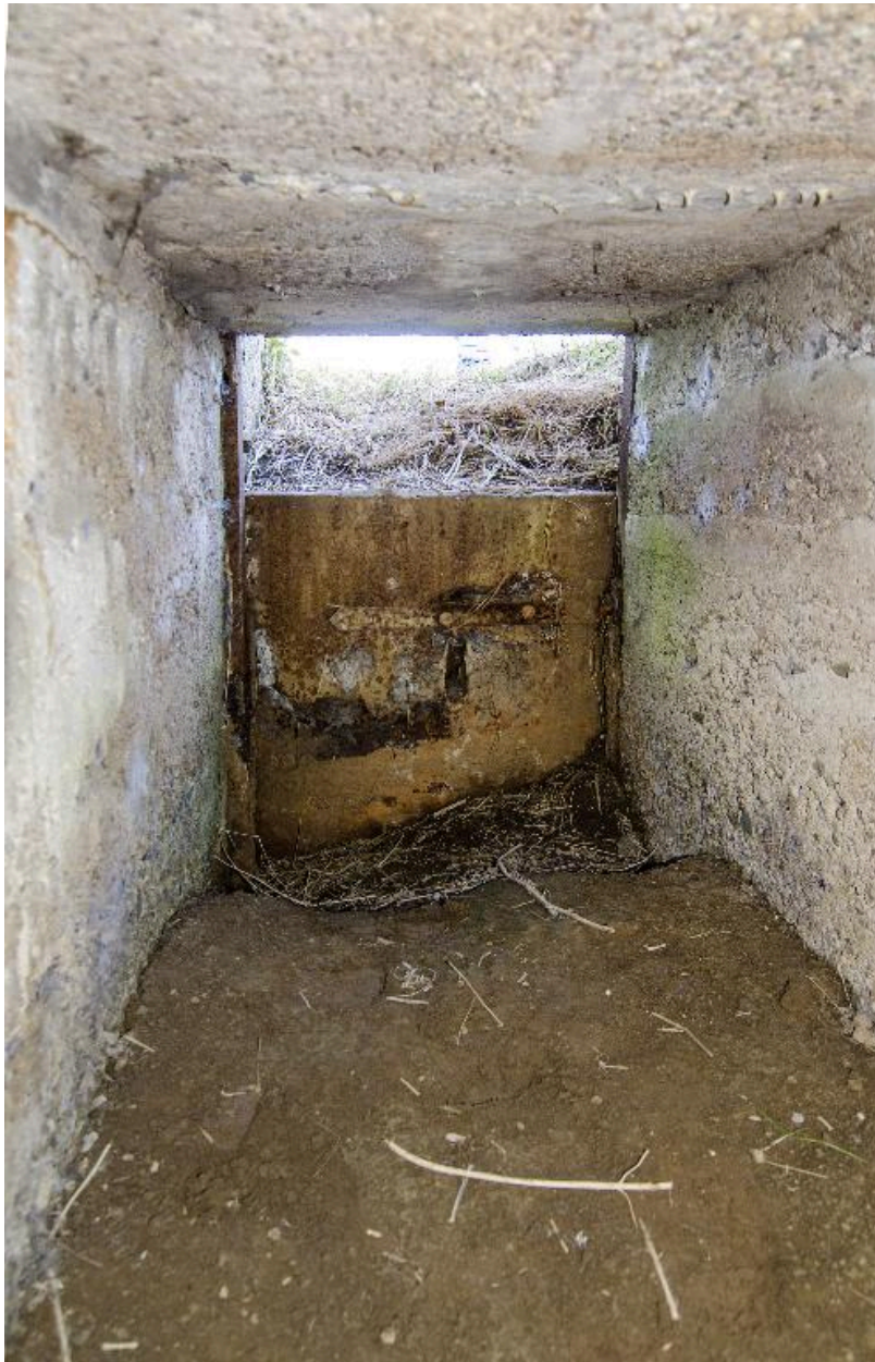
Vue intérieure du porche pare souffle. L'un des deux accès.
