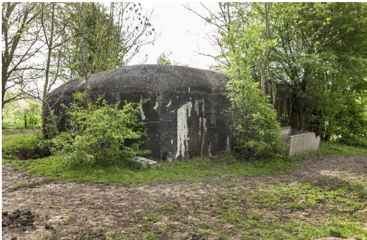
Vue de trois-quarts vers le sud
