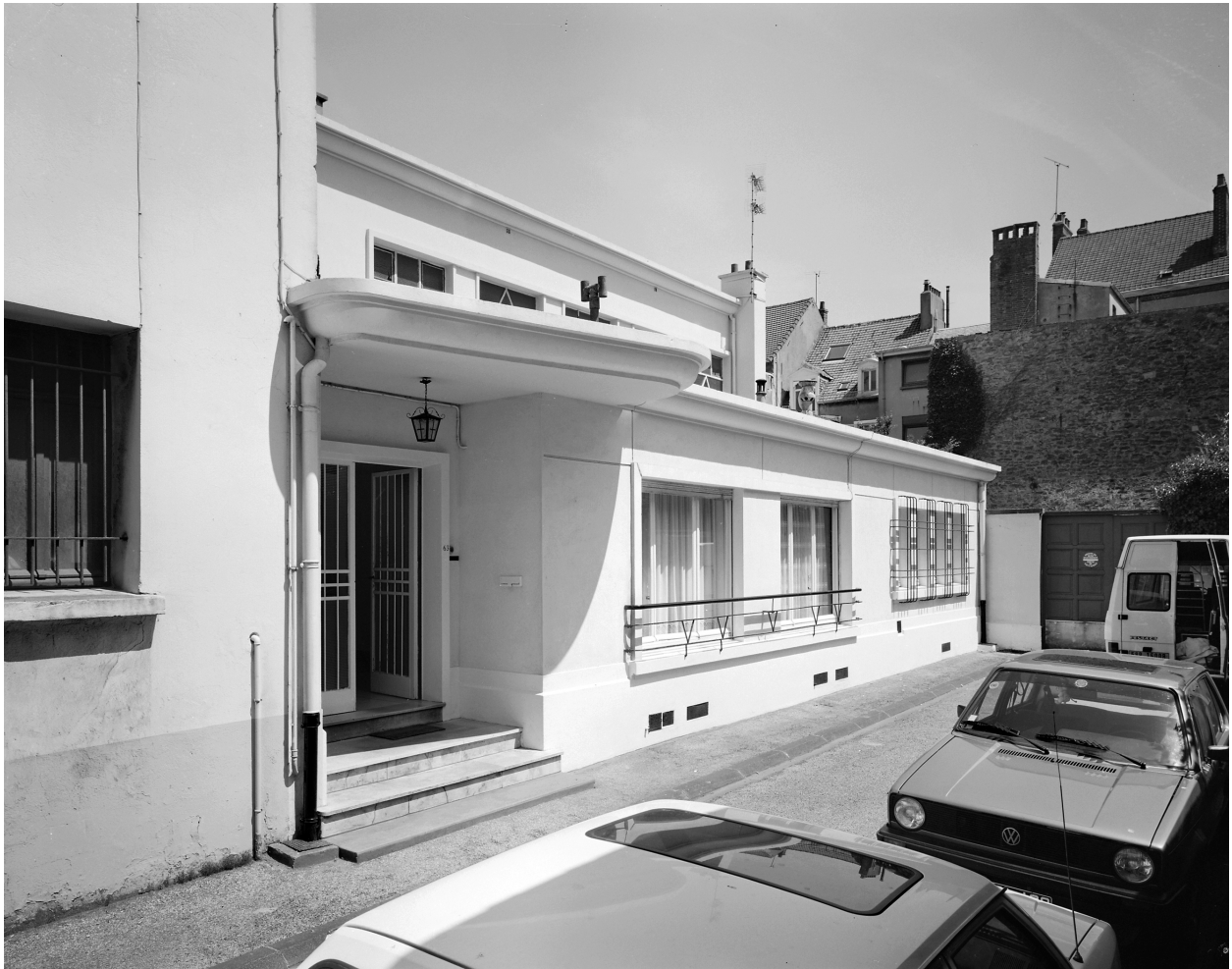
Synagogue, vue d'angle sur voie.
