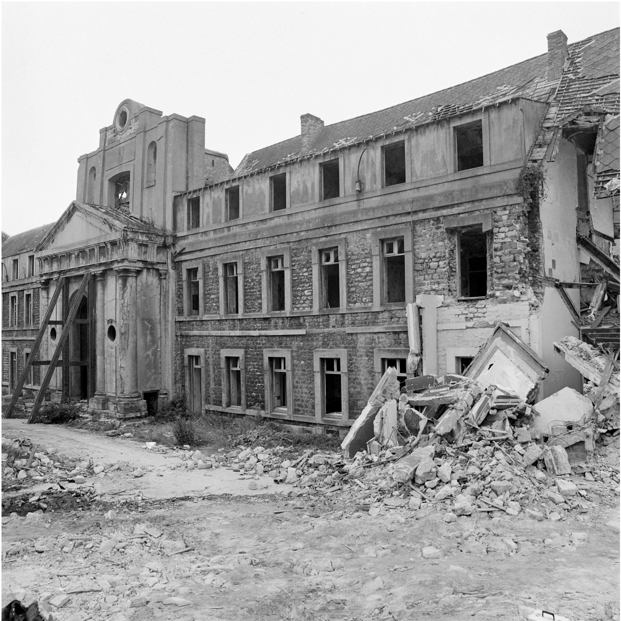
Bâtiment C, chapelle, vue d'ensemble sur cour.
