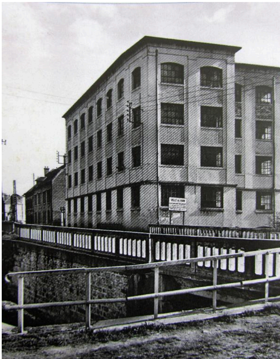
La minoterie Filou-Damay reconstruite, après 1930 (coll. part.).
