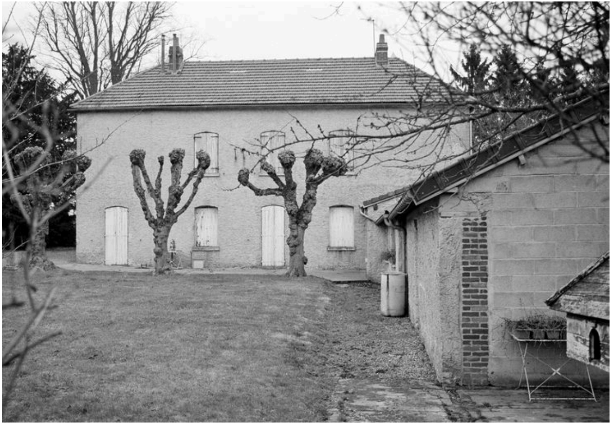
Logement patronal : façade postérieure et dépendance.
