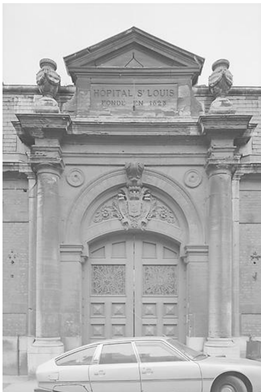
Bâtiment A, portail d'entrée, façade sur voie.
