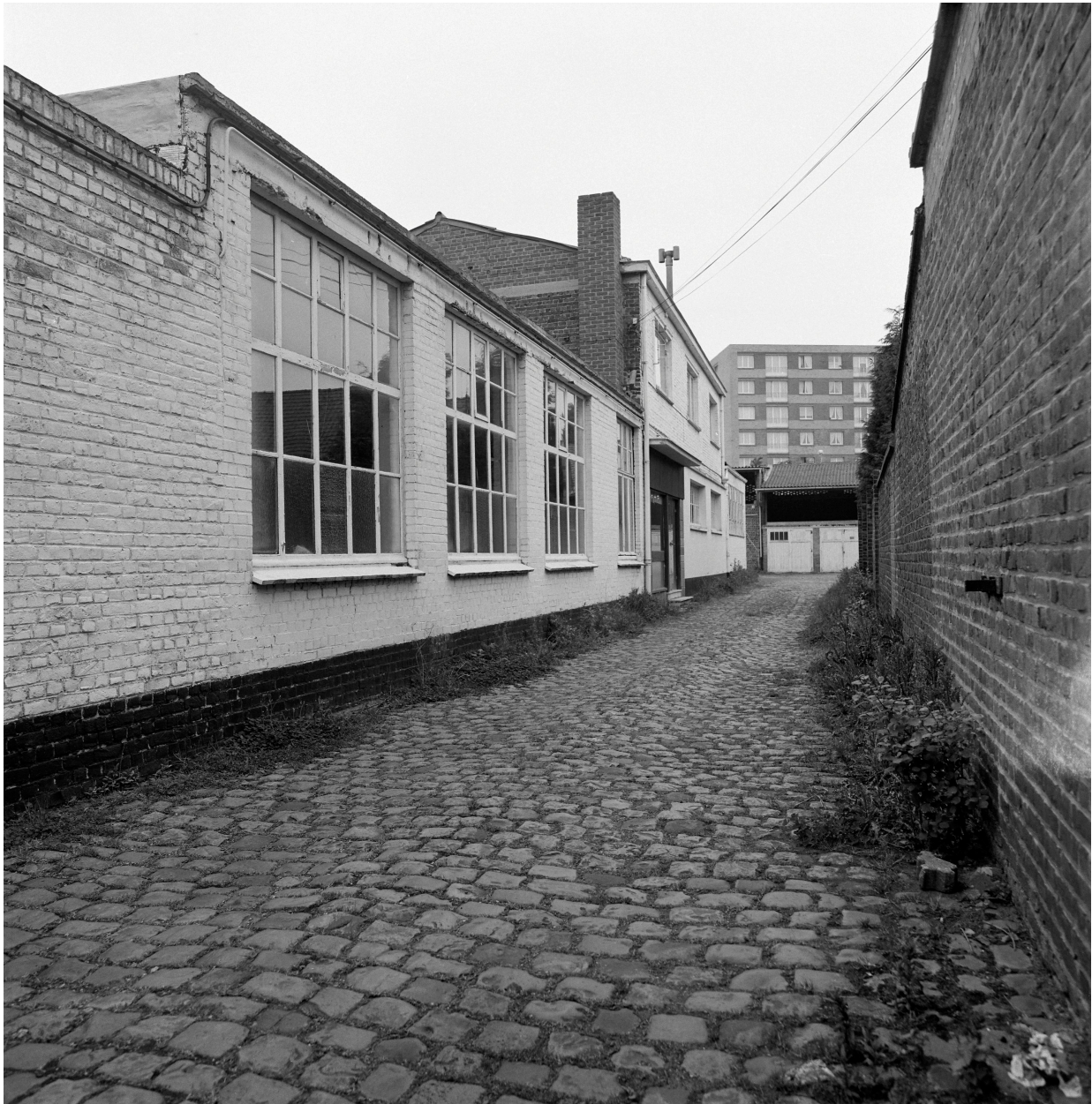
Atelier de fabrication. Vue prise vers le nord-est.
