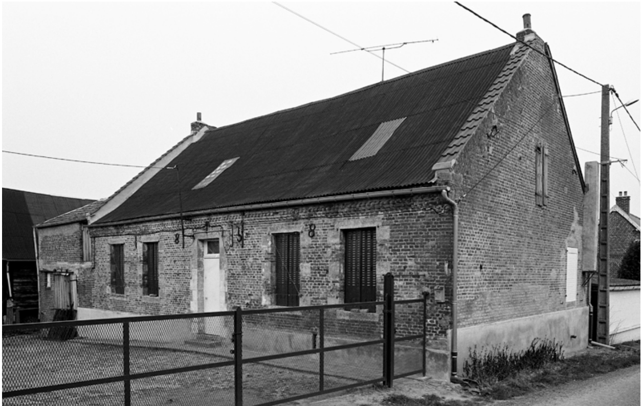
Vue d'ensemble du logis, depuis le sud-ouest.
