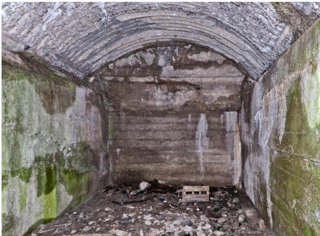
Bâtiment B, vue intérieure
