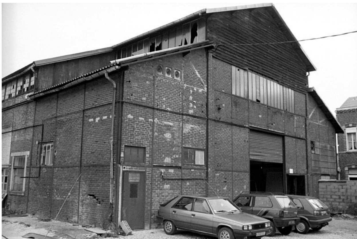
Atelier de fabrication, élévation antérieure.
