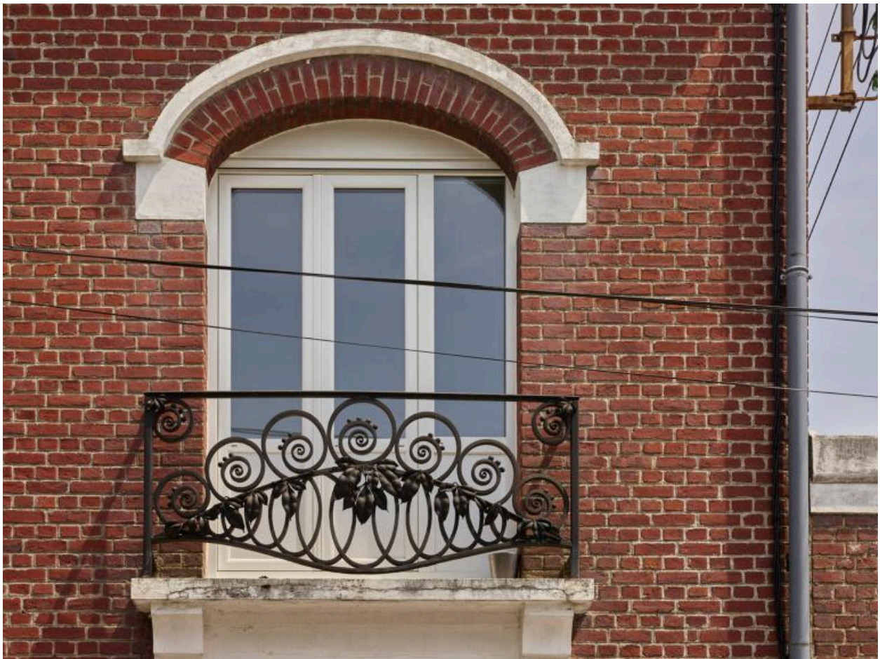
Maison, n° 34 rue Gambetta. Vue de détail du garde-corps du balcon à motifs géométriques et floraux Arts déco.
