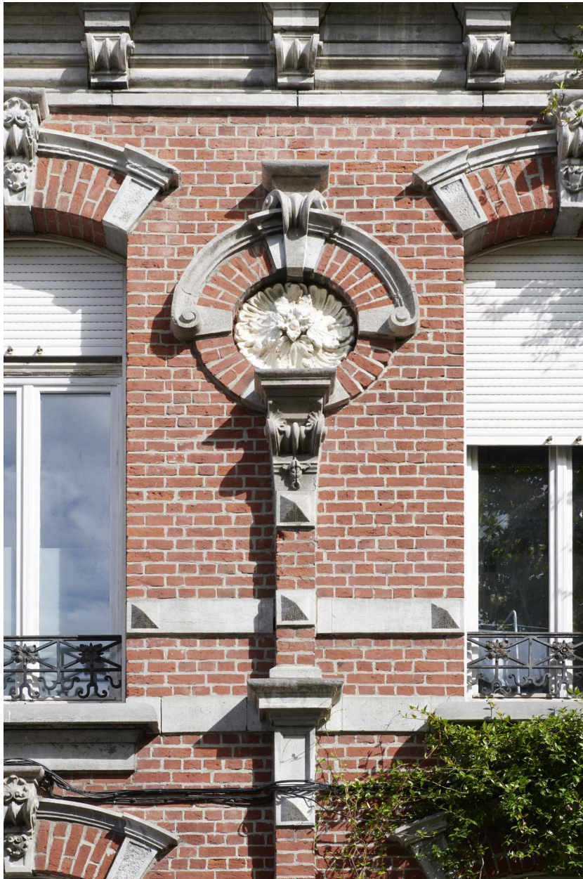
Détail : médaillon sur façade place Édouard-Roussel.
